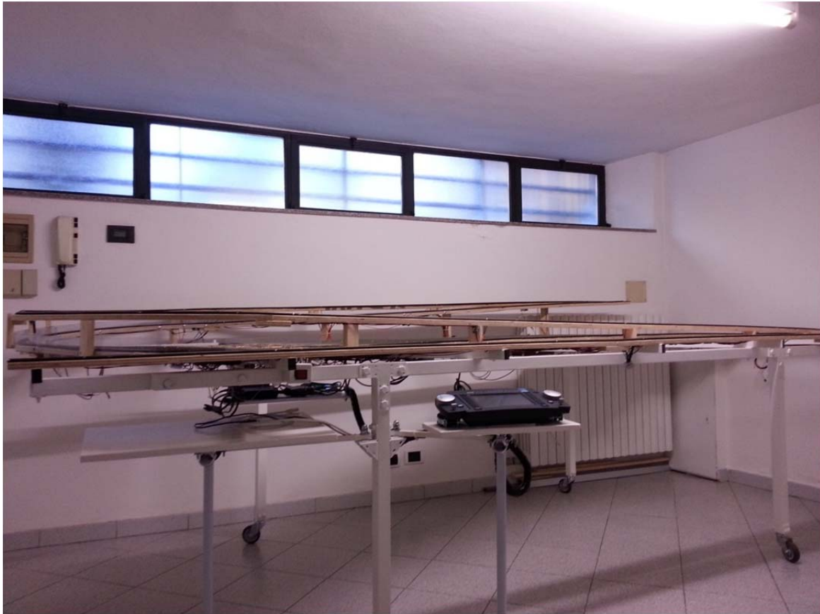
Vista delle pendenze
